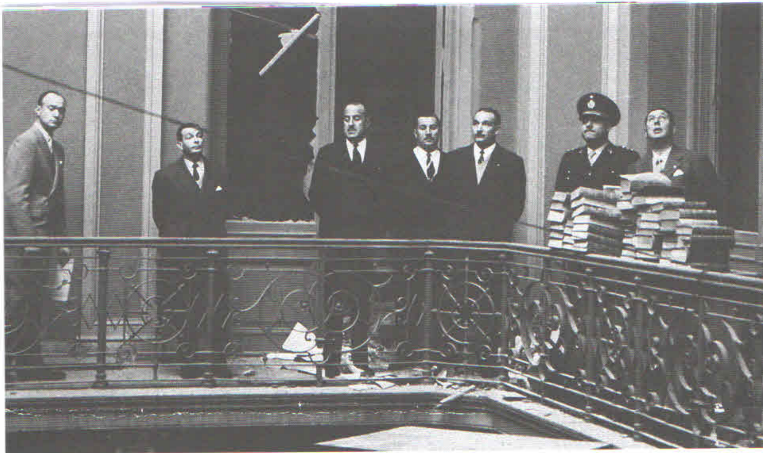
El General Perón observa los daños en Casa de Gobierno tras los bombardeos. 16 de junio de 1955.
